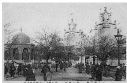
No.007 大正博覧会鉾山館・林業館・音楽堂
