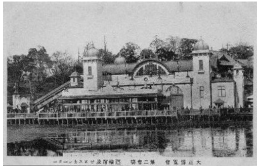
No.003 大正博覧会運輸館及びエスカレーター
