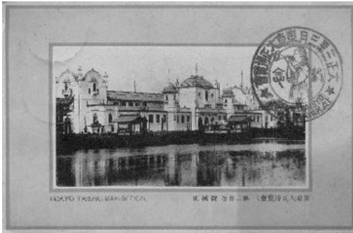
No.017 大正博覧会 機械館
